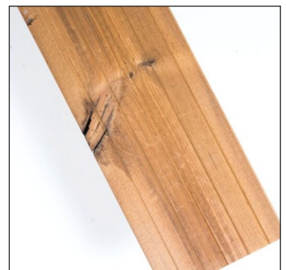
Praskliny kolem suků jsou povoleny
