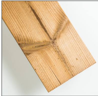
Trhliny na koncích prken jsou povoleny
