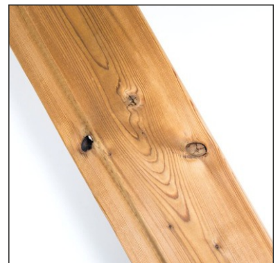
Malé otvory po vypadlých sucích jsou povoleny
