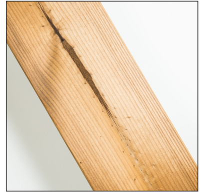
Dřeňové záběhy jsou povoleny
