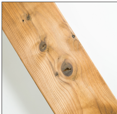
Praskliny v sucích jsou povoleny
