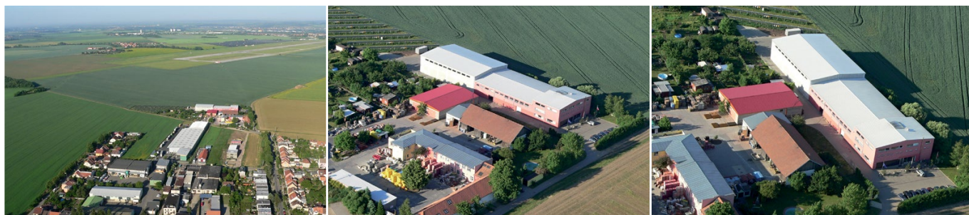
Pohled na výrobní areál.
